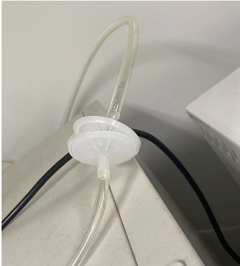
进气过滤器炸裂
